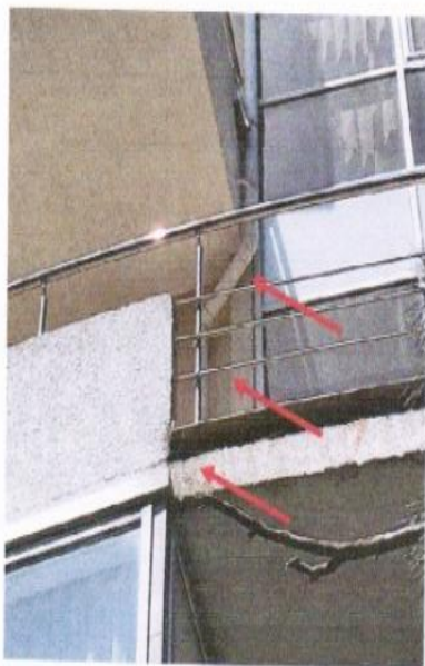
Фото 13. Изменение траектории прокладки водосточной трубы на 3-м этаже.
