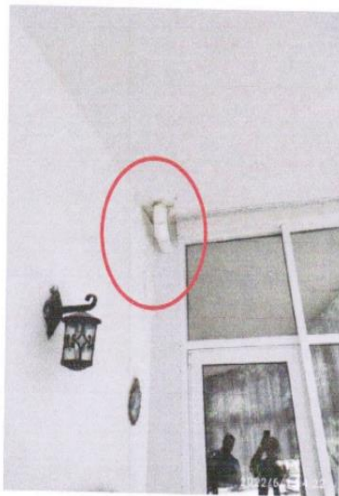
Фото 11. Место затопления балкона – проход водосточной трубы дома через балкон 3-го этажа вверх на второй этаж и выход за пределы балкона.
