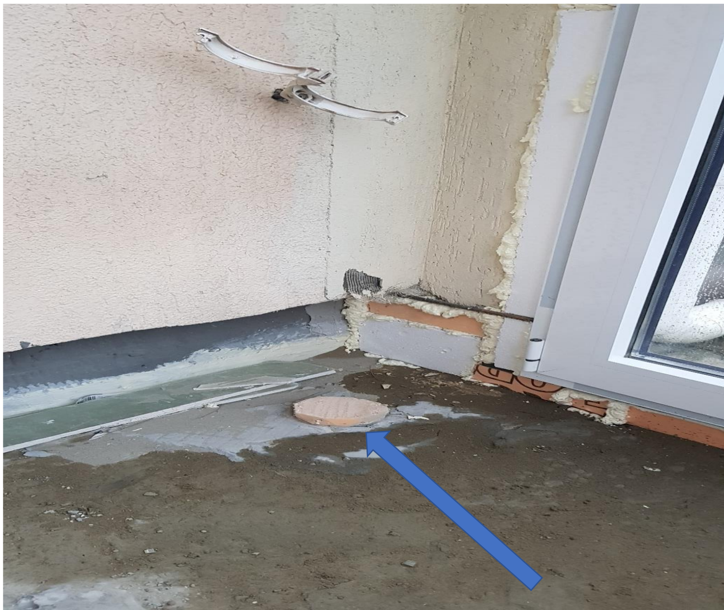
Фото: Место прохода водосточной трубы, Заглушка
