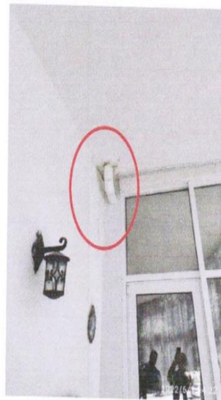
Фото 11. Место затопления балкона – проход водосточной трубы дома через балкон 3-го этажа вверх на второй этаж и выход за пределы балкона.
