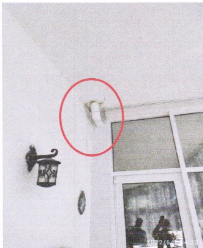
Фото 11. Место затопления балкона – проход водосточной трубы дома через балкон 3-го этажа вверх на второй этаж и выход за пределы балкона.
