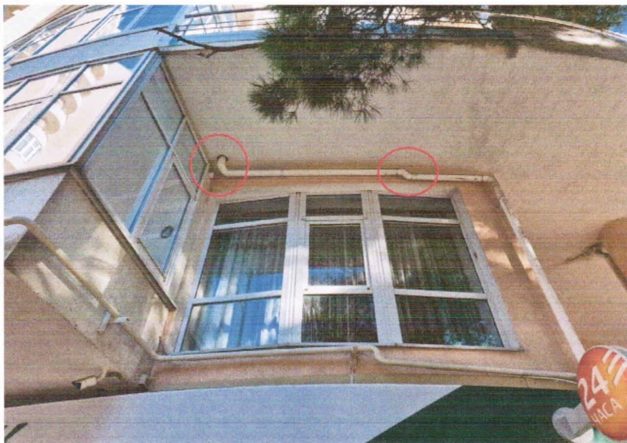
Фото 3. Препятствие кондиционером прохождению трубы через балкон 2 этажа.
