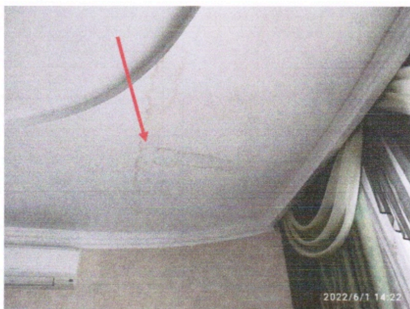
Фото 12. Следы намокания потолка в гостиной.
