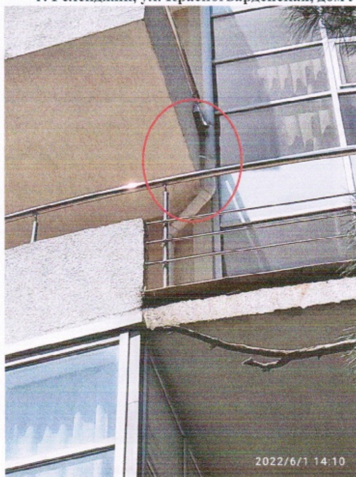
Фото 1. Переход трубы снаружи на балкон 3 этажа – без необходимости.
