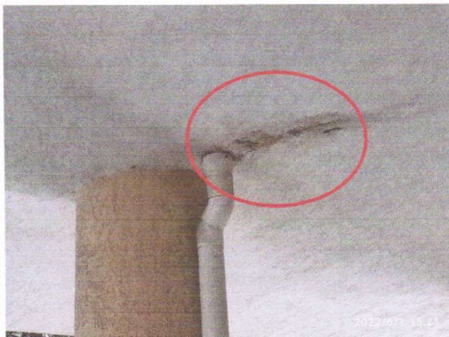
Фото 6. Протекание в месте прохода водосточной трубы через перекрытие 1 этажа. Элементы водосточной трубы собраны против потока воды.
