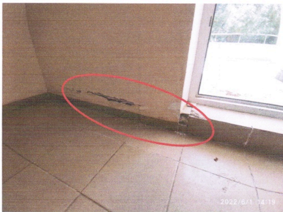
Фото 9. Разрушение стен от намоканий с балкона 3-го этажа.
