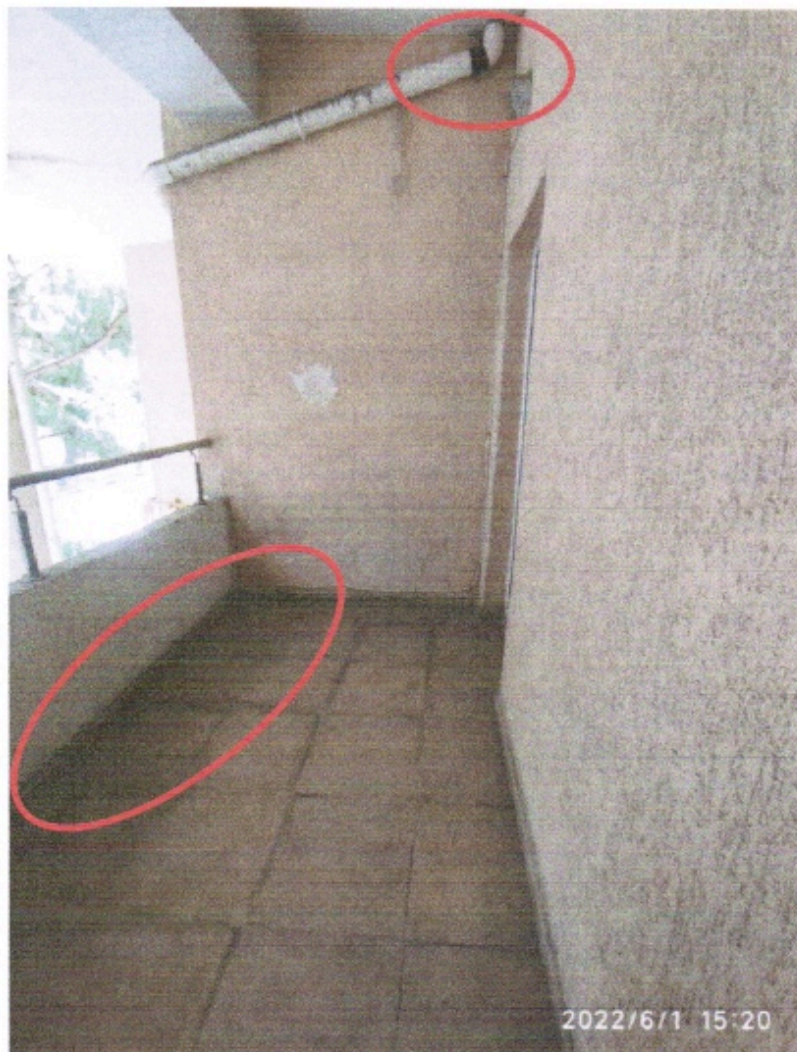
Фото 8. Отсутствие стоков воды из лоджии. Следы застоя воды на полу. Следы намокания стен.
