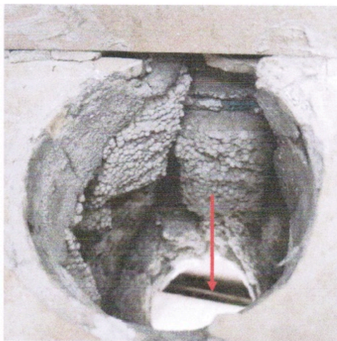
Фото 14. Состав балконной плиты - легко водопроницаемые негерметичные материалы. Электрический кабель светящейся вывески Сбербанка.
