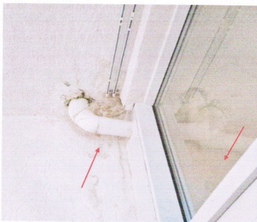
Фото 6. Обрезки трубы на балконе 2 этажа после переноса. За окном видна перенесенная труба.
