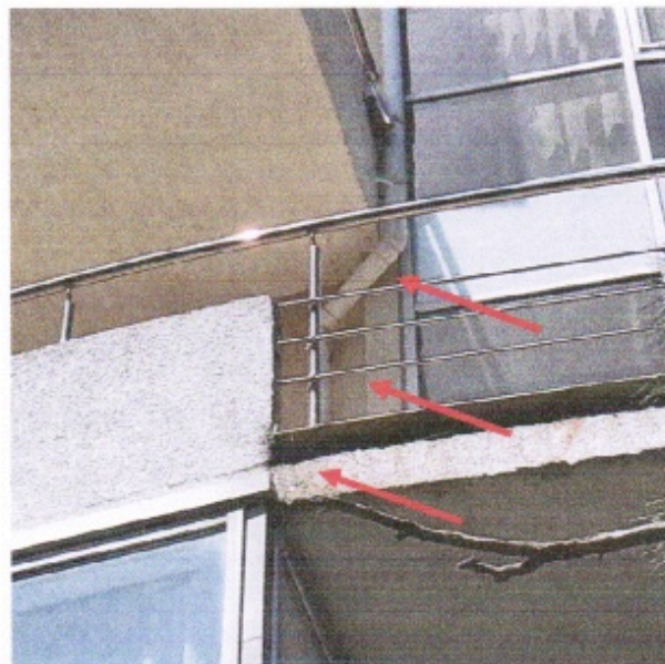
Фото 13. Изменение траектории прокладки водосточной трубы на 3-м этаже.
