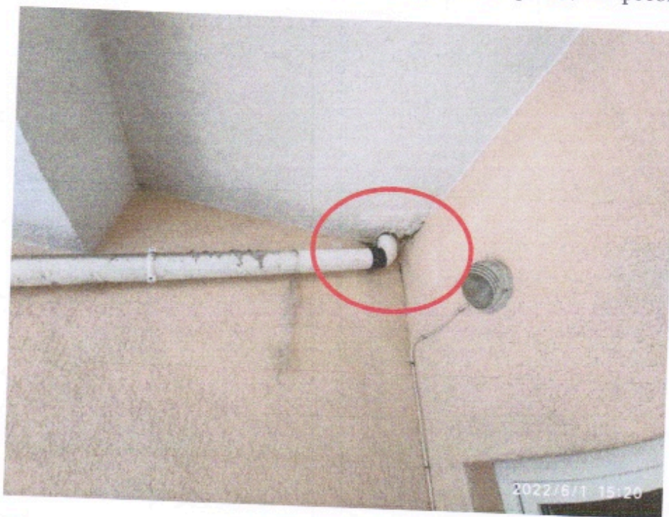
Фото 5. Протекание в районе прохода водосточной трубы через перекрытие 1-го этажа.
