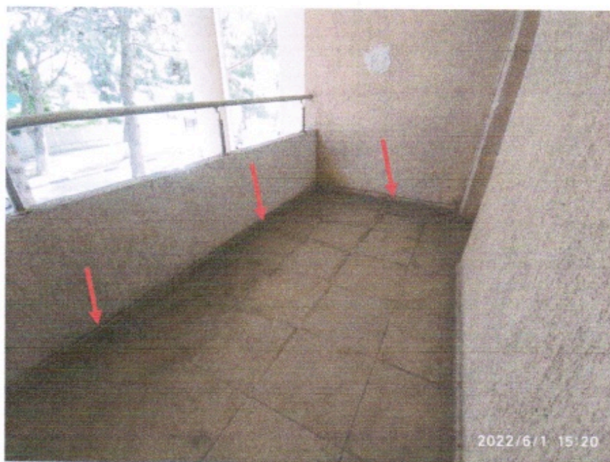
Фото 15. Балкон с электрическим проводом в зоне затопления. Отсутствуют сливные отверстия.
