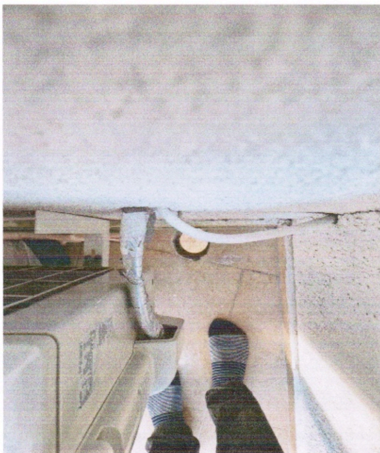
Фото 3. Препятствие кондиционером прохождению трубы через балкон 2 этажа.
